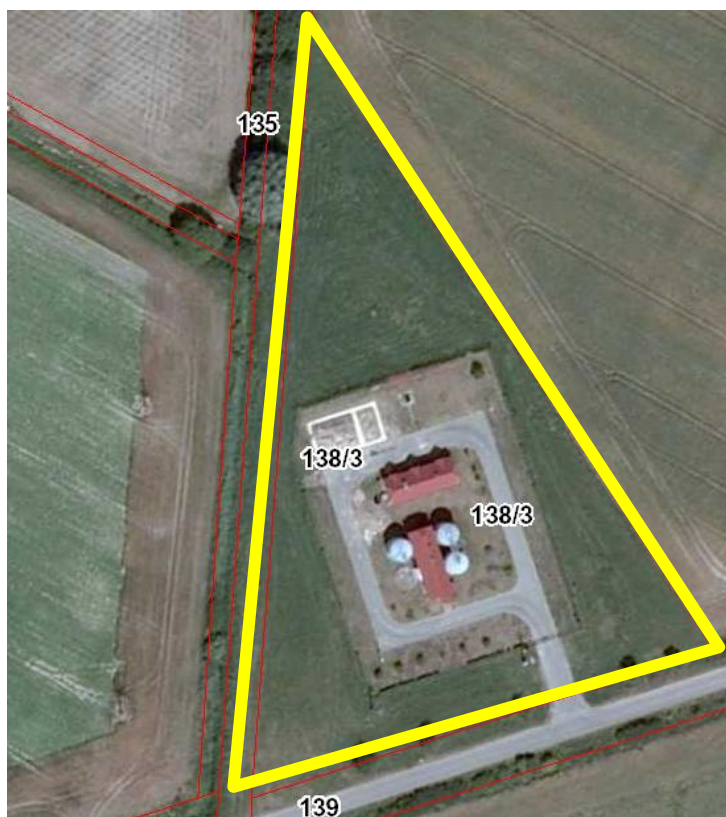
Rysunek nr 44. Możliwość montażu instalacji fotowoltaicznej na terenie Oczyszczalni ścieków w Niechanowie, ul. Topolowa
